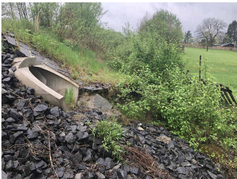
Obr. 3 Výtok se šikmým čelem propustku
