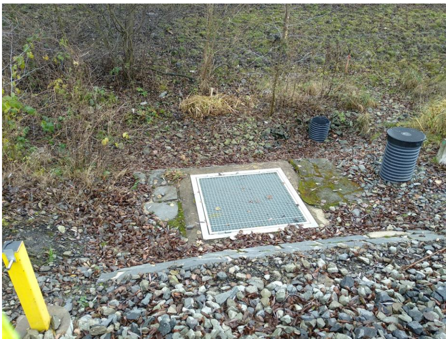
Obr. 2 Vtok propustku s pochozím roštem
